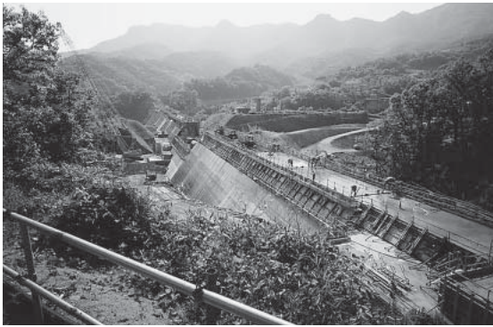
建設が進む新内海ダム(山中先生撮影)
