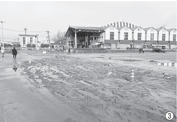
①輪島市内で1階部分が倒壊した建物、②輪島市内では道路に亀裂が入って通行に支障を来していた、③地震による液状化で水浸しになった駐車場(七尾市内)
