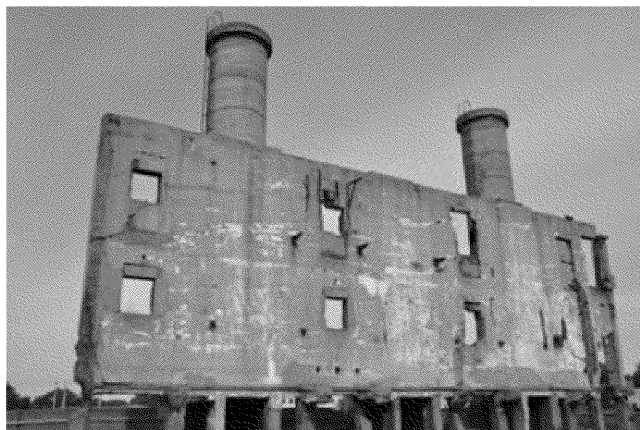
731部隊跡に僅かに残るボイラー棟の残骸
