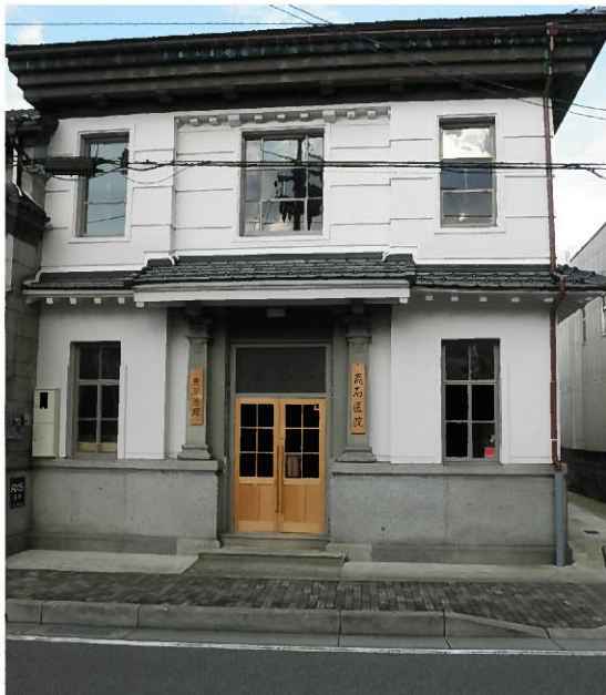
昭和初期に建てられた但馬貯蓄銀行の跡地をリフォームした診療所
