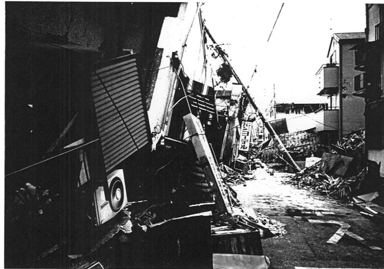
震災当時の様子 地震により住宅は倒壊
